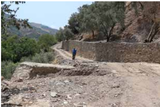
Haydarlı mah. Yeni açılan yola istinat duvarı yapımı işi
