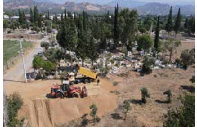
Arslanlı Mezarlığı genişletme çalışmaları
