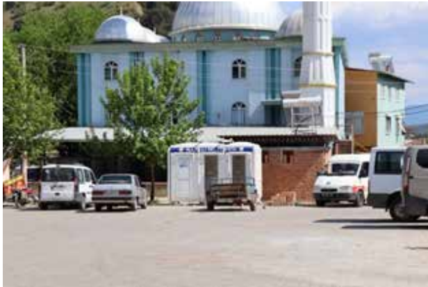
Bayındır Mah. Caminde WC ve Gasilhane Yapımı
