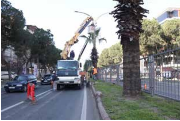
E87 Yolu Işılandırma ve yenileme çalışmaları
