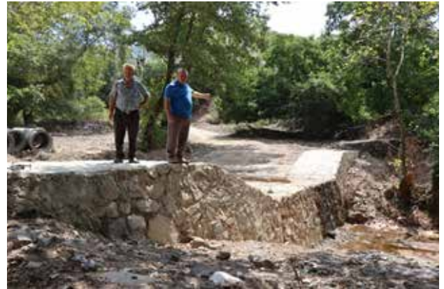
Haydarlı Mah. Dere geçişlerine istinat duvarı yapım işi
