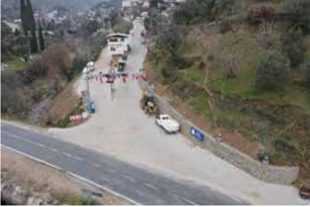
Işıklar Mah. Yol bakım Çalışmaları
