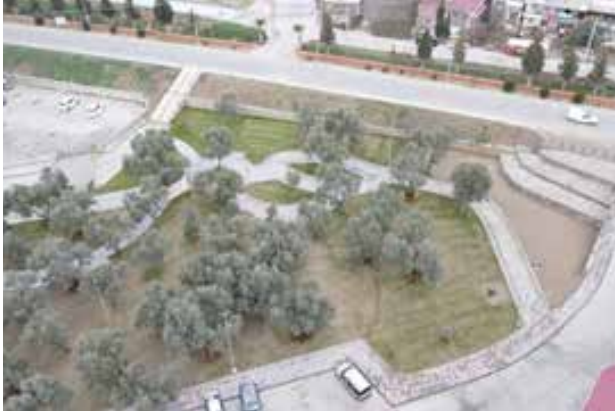
S. Demirel Parkı İstinat Duvarı ve Merdiven yapımı
