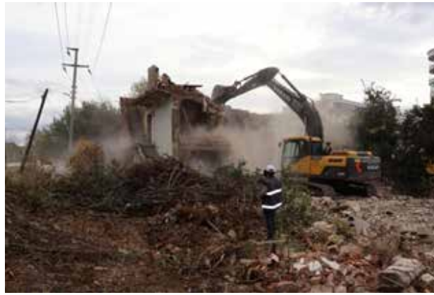
Yeşil Mah. metruk Bina yıkımları
