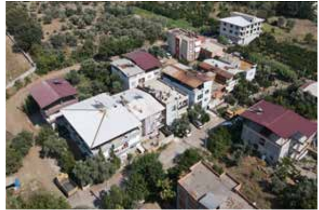
Bozyurt Mah. Yol Yapım Çalışmaları
