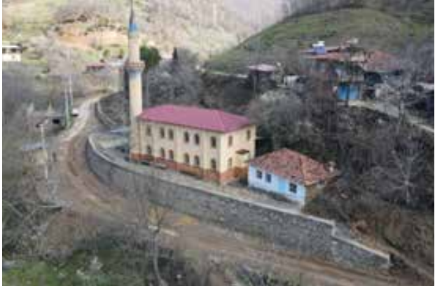
Kuşçular Mah. istinat duvarı yapımı
