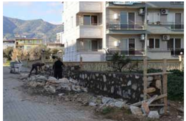
İsabeyli mah. Su deposu yanı istinat duvarı
