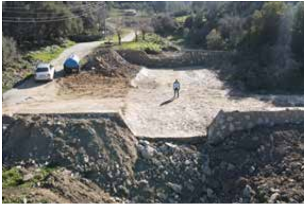
Dualar mah. Ocak taşı ile harçlı su bendi yapımı
