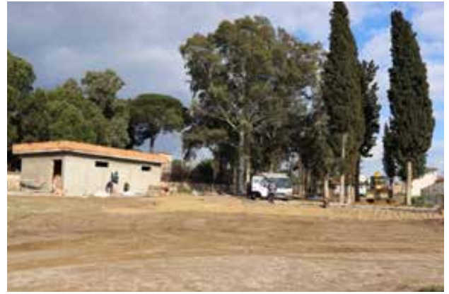
Sümer Deve Güreşi sahasına bay-bayan WC yapımı
