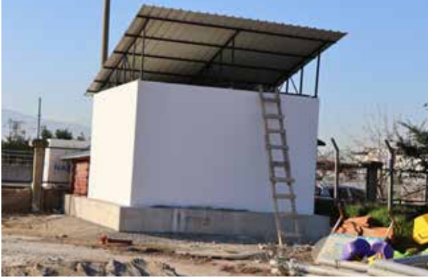
Yeni Sanayi Mah. 40 tonluk su deposu yapımı
