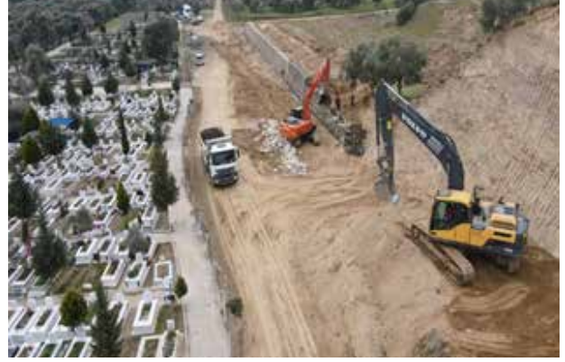
Eğriboyun Mezarlığı Genişletme çalışmaları
