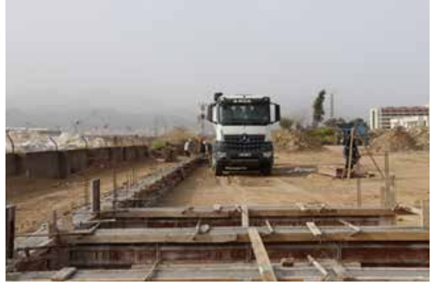
Katı Atık Toplama Birimi İnşaatı
