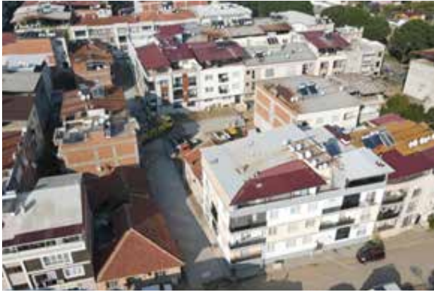
Aydoğdu Mah. 364 ve 79 Sok Yol düzenlemesi
